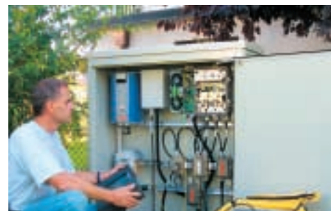
Inbetriebnahme eines O/E-Wandlers
