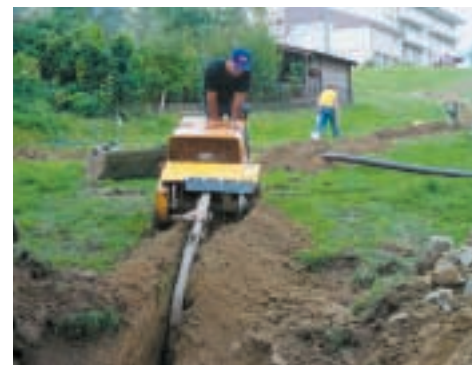
Unsere Baugruppe beim Trasseneubau
